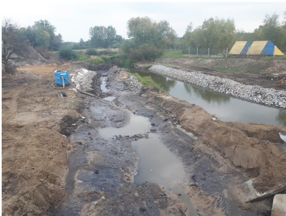
Fot.7. Odpompowywanie wody z odmulanego odcinka Widawy powyżej mostu na ul. Rzecznej – Zadanie 1
