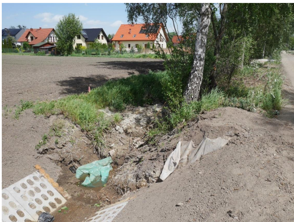
Fot.16. Brzoza kolidująca z wykonaniem zabruków na rowie R-K 9. Odhumusowanie do pnia drzewa wiązałoby się z utratą statyki przed drzewo i jego powolne zamieranie. Drzewo zachowano. Odkryte korzenie przykryto włókniną (widoczna na zdjęciu) na czas profilowania skarpy, aby zapobiec ich wysuszeniu. Skrócono zakres umocnień – Zadanie 2
