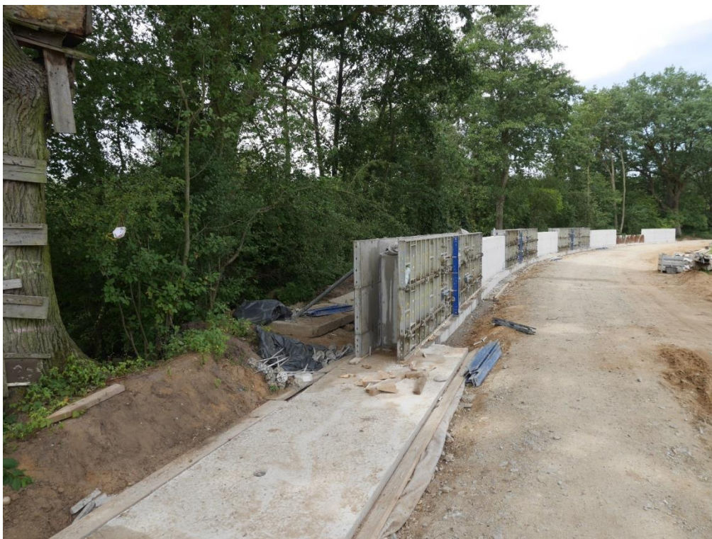
Fot.5. Budowa oczepów przy alei dębowej nr 28 – Zadanie 1
