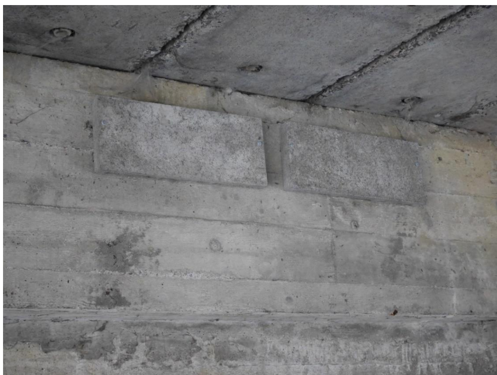
Fot.14. Powieszone dwie budki dla nietoperzy z trocinobetonu pod mostem nad Widawą, w ciągu ul. Rzecznej – Zadanie 1
