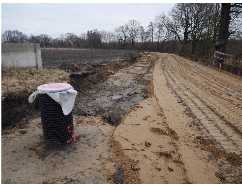
Fot.4. Drenaż wzdłuż budowanego wału przeciwpowodziowego na pierwszym odcinku realizacyjnym, wzdłuż alei dębowej nr 28 – Zadanie 1
