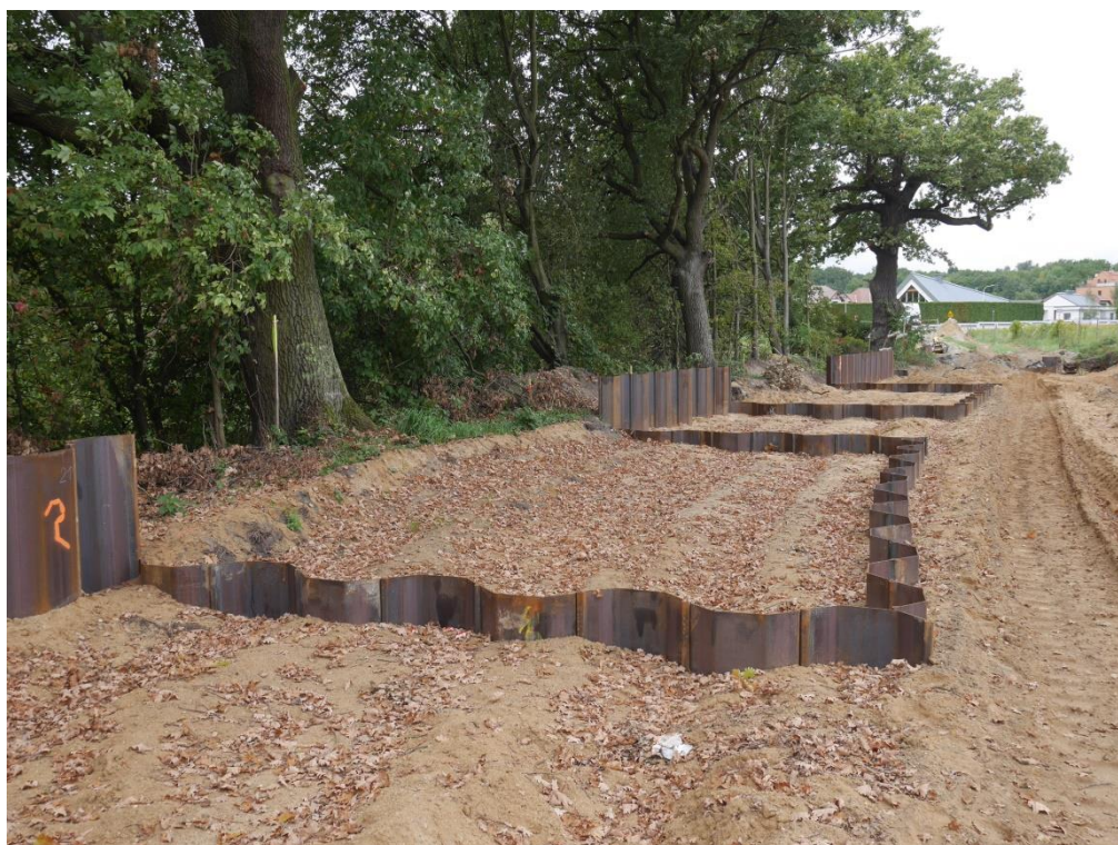
Fot.3. Wykonane obejścia ściankami szczelnymi korzeni dębów w obiekcie przyrodniczym nr 28 – Zadanie 1
